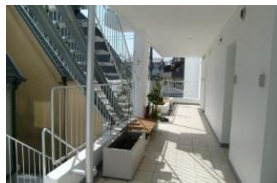
外廊下は南向きで明るい！
